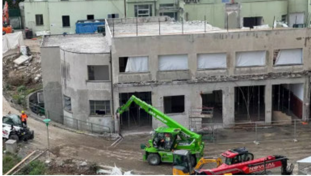
LAVORI IN CORSO al Gaslini per l'abbattimento del padiglione 8
