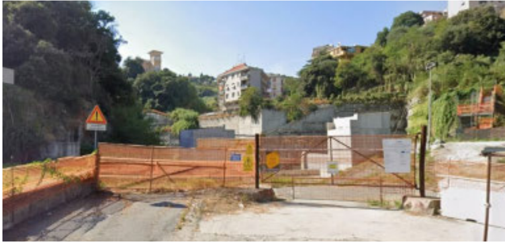
Il cantiere (fermo) dell'Aurelia Bis a Savona (foto da post FB del sindaco Russo)
