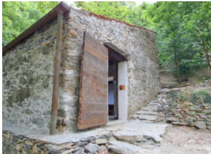
Una delle casette ristrutturate e pronte per l'accoglienza
