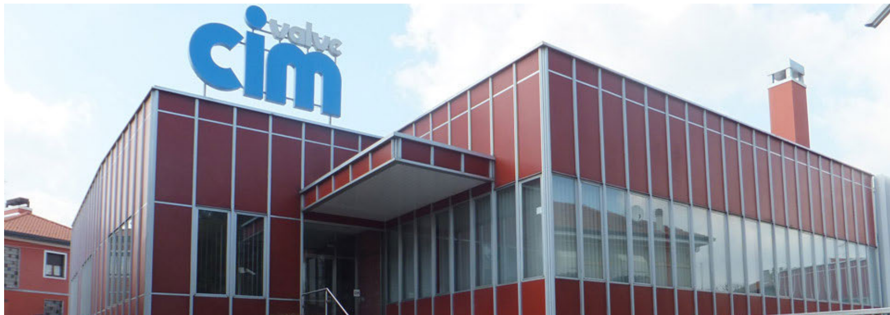
La sede direzionale della Cimberio a San Maurizio e sotto l'AD dell'azienda Roberto Cimberio
