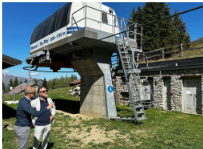
L'assessore Piana, sulla destra, supervisiona l'impianto
