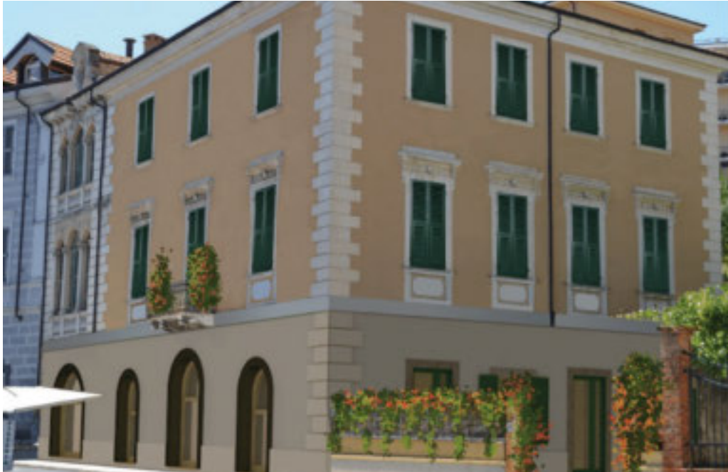
Il palazzo ristrutturato, così com'era presentato sul render
