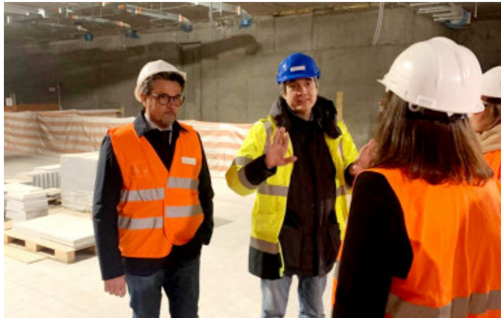
Il presidente Mauro Fava (a sinistra) al sopralluogo nel cantiere
