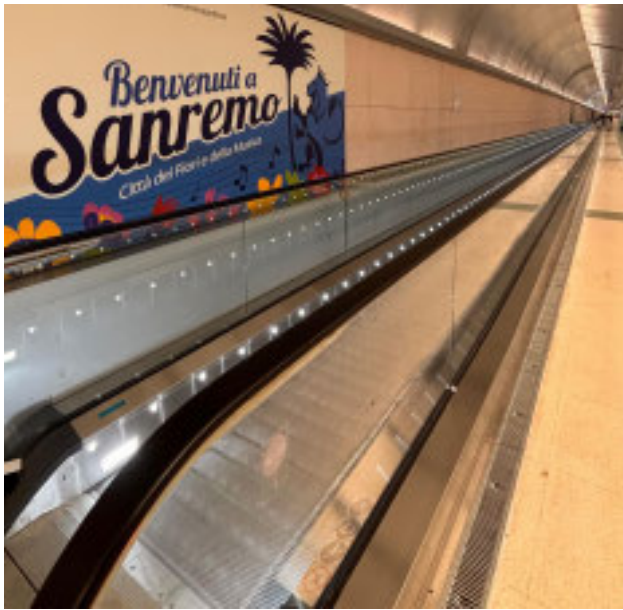
IN STAZIONE Uno dei nuovi tapis roulant
