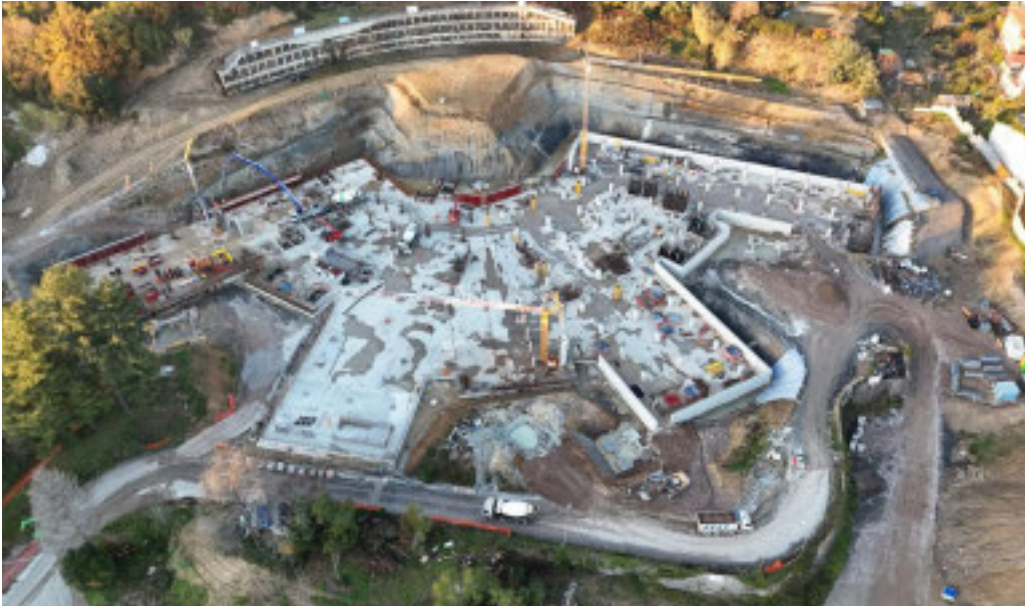
Le fondamenta dove sono stati scavati 80mila metri cubi di terre e rocce
