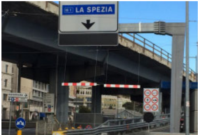
L'INGRESSO A PONENTE Della Sopraelevata di Genova
