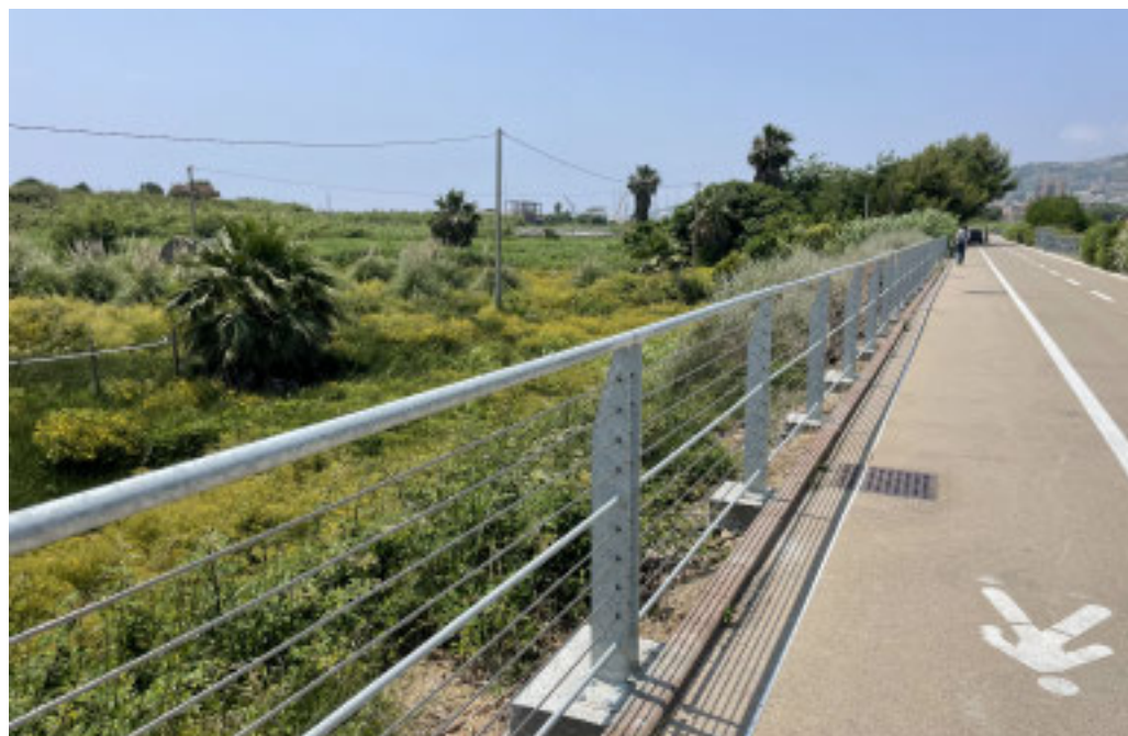
I parapetti nuovi tra Ospedaletti e San Lorenzo al Mare
