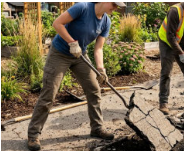
DEPAVING Rompere l'asfalto per dare spazio al verde
