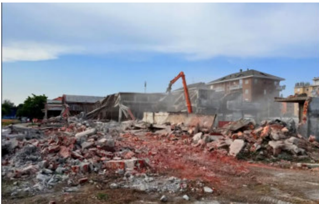
La demolizione dell'ex palazzina ATAP di Viale Macallè
