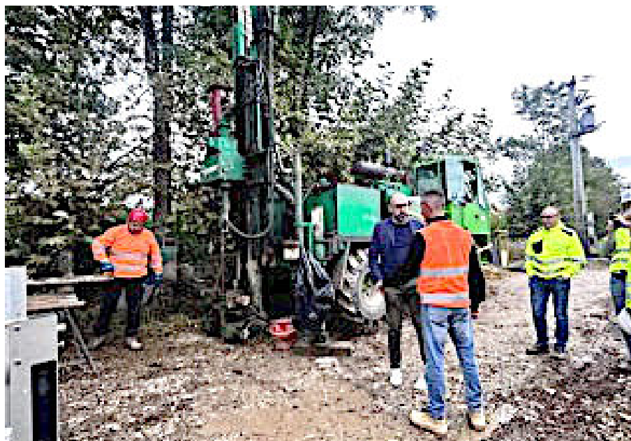
Il sopralluogo a Centallo
