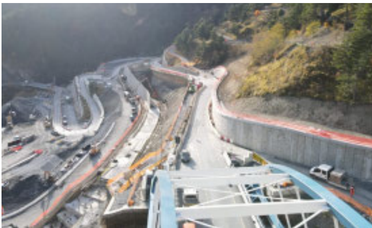
Lavori alla galleria del Tenda bis
