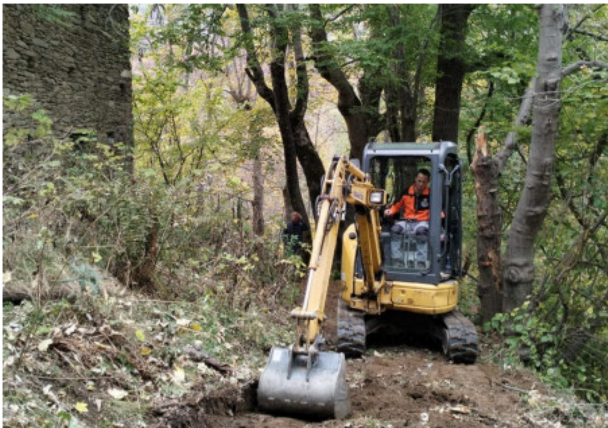
I lavori al sentiero del Faggio di Sampeyre
