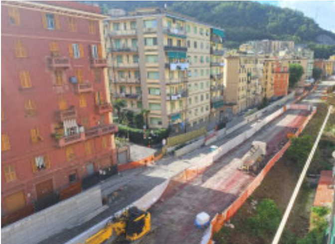
Il cantiere di Certosa, quartiere genovese della Valpolcevera
