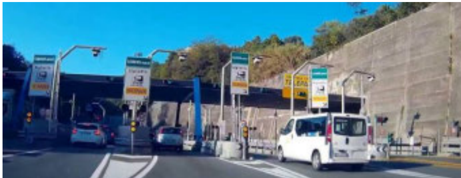
Il casello autostradale d'ingresso di Genova Ovest sull'A10
