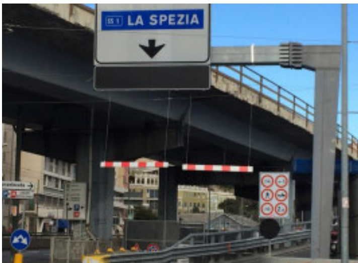
UNA DELLE RAMPE DI ACCESSO Della Sopraelevata Aldo Moro
