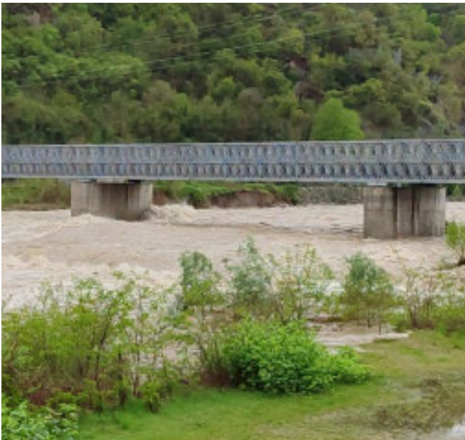
Il ponte chiuso tra Romagnano Sesia e Gattinara
