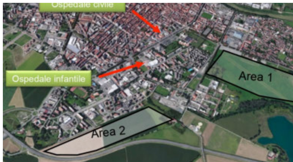
L'area su cui sorgerà il nuovo ospedale
