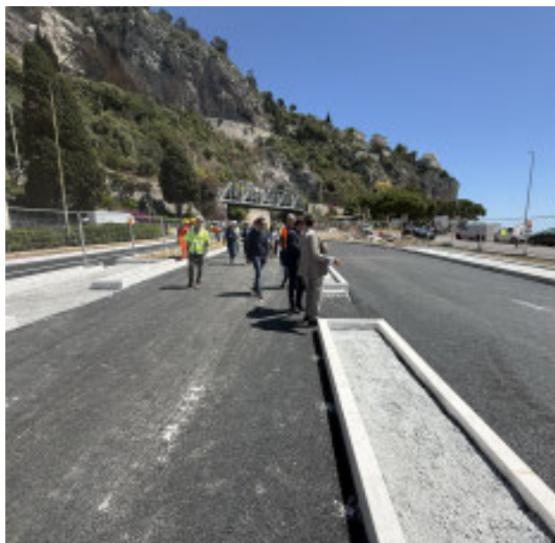
AURELIA ZONA BALZI ROSSI Il sopralluogo di ieri
