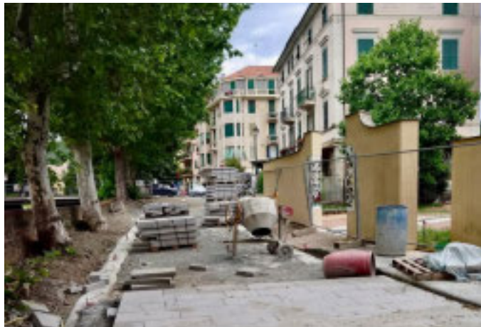
Lavori nel centro storico di Albisola Superiore
