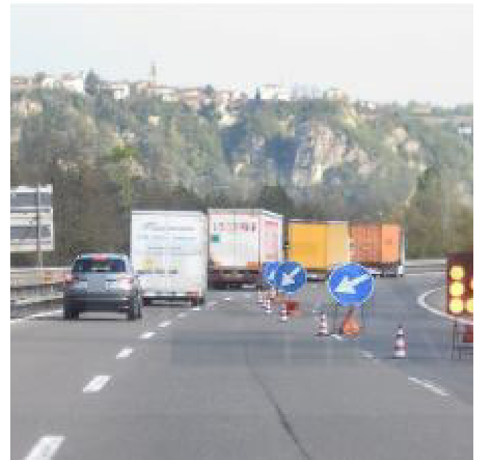
I cantieri provocano disagi sulla Torino-Savona
