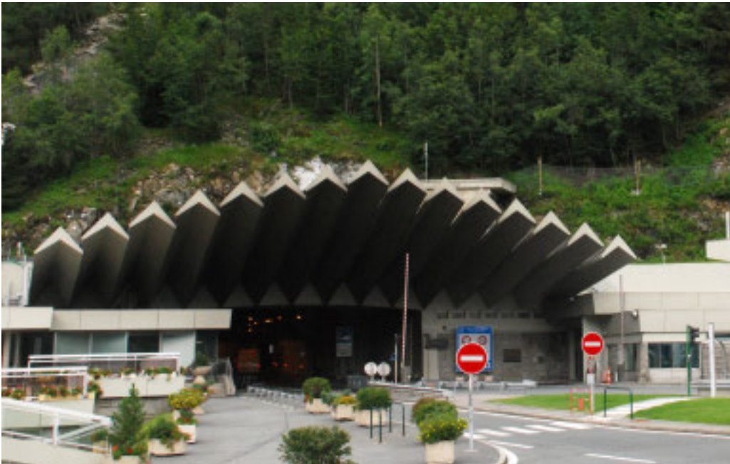
Tra il 2024 e il 2025, c'è un investimento complessivo di 50 milioni di euro nella galleria
