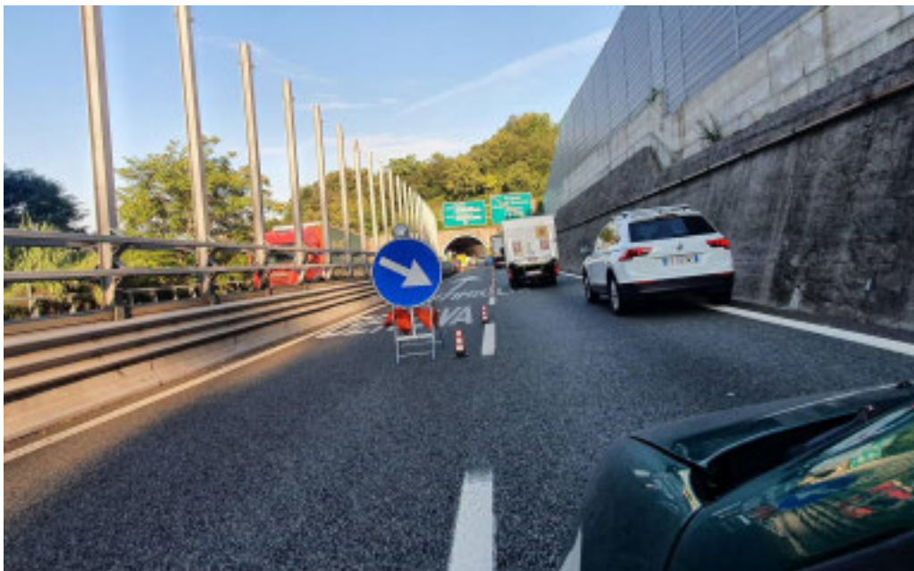
Restringimenti e scambi di carreggiata sull'Autofiori dopo la sospensione dei cantieri
