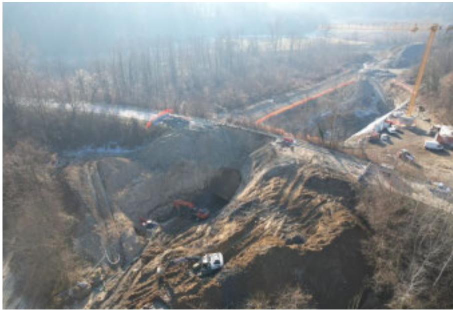
Il tratto di Fondovalle Tanaro interessato dai lavori
