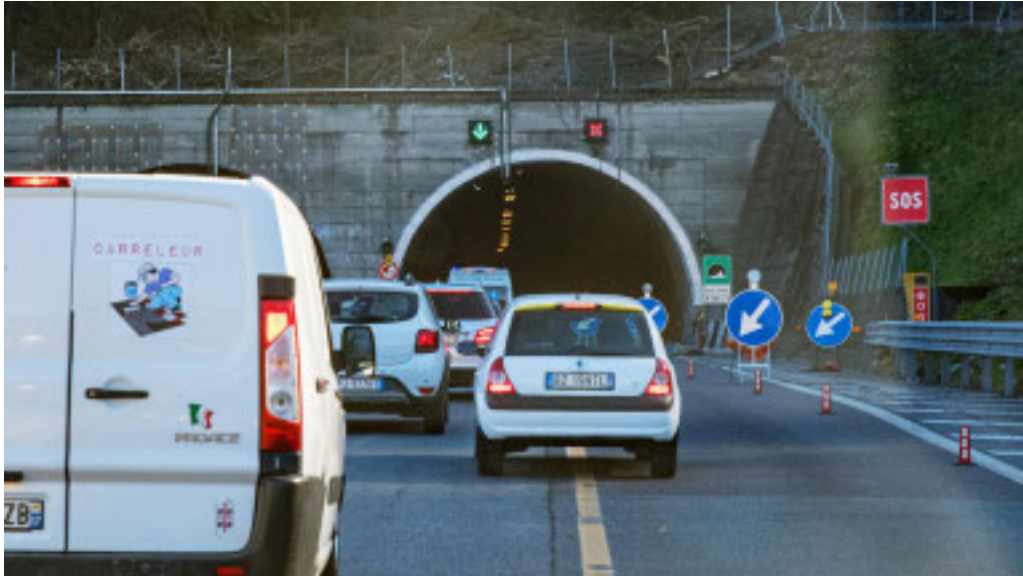
Cantieri lungo la tratta Savona-Ventimiglia per l'adeguamento di gallerie e viadotti
