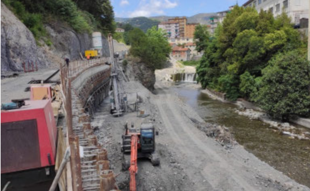
L'immagine di uno dei cantieri, dove si vede la vicinanza alle case
