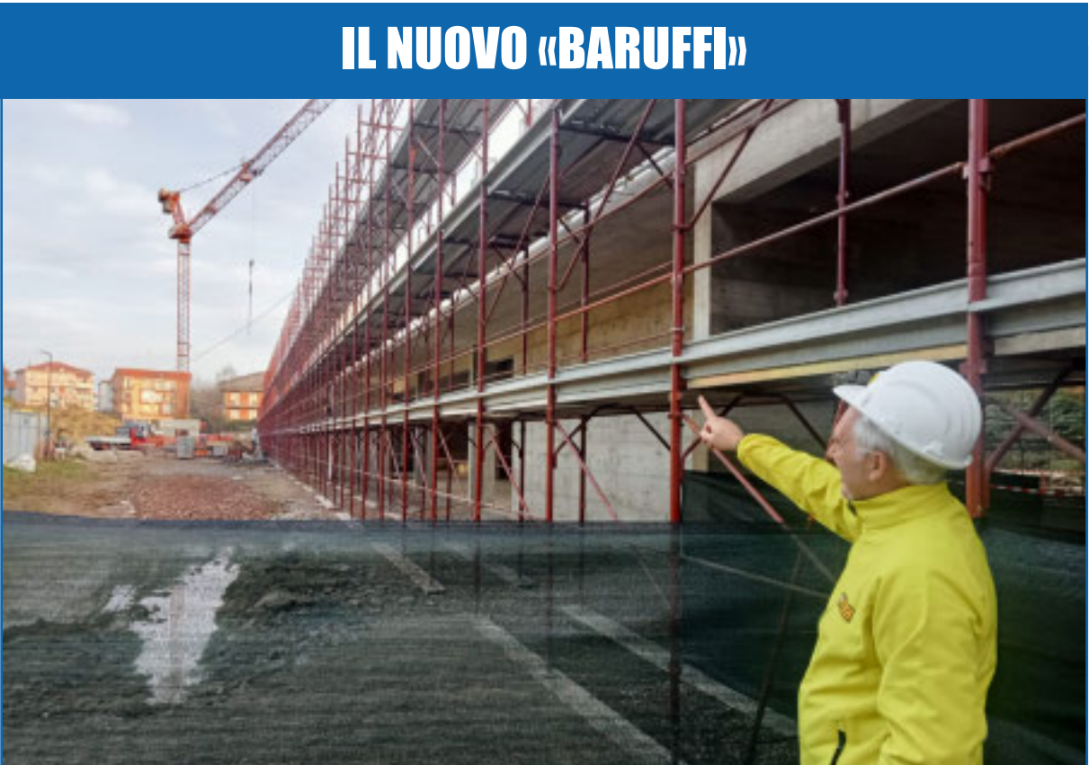
Immagini dal cantiere - A PAG. 19
