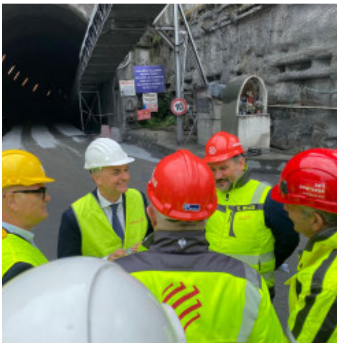
Cantiere di Vallemme, ieri sopralluogo di Rixi
