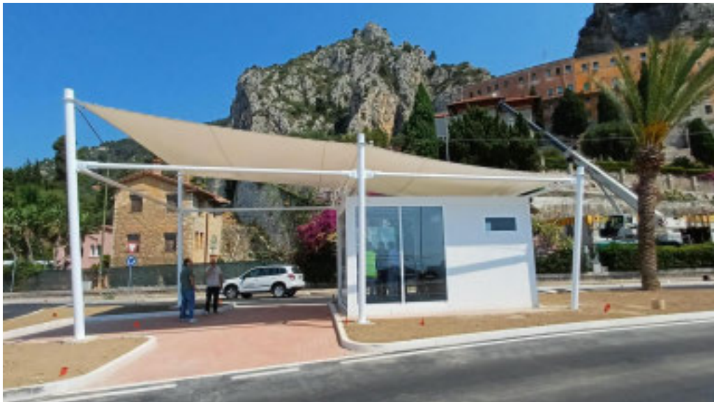
La nuova struttura prefabbricata costata 75mila euro
