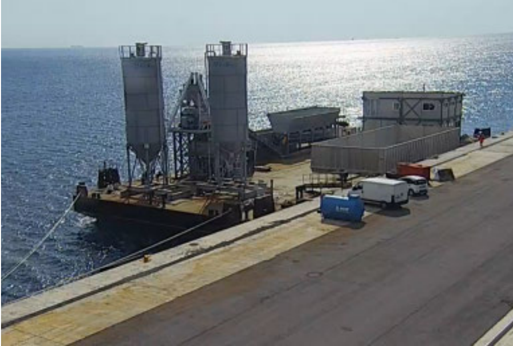
Un impianto per il riempimento dei cassoni nel porto di Vado Ligure
