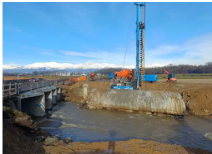
I lavori per il ponte sul Rio Ottino
