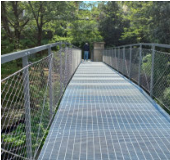
ACQUEDOTTO STORICO La zona di Ca' de rissi
