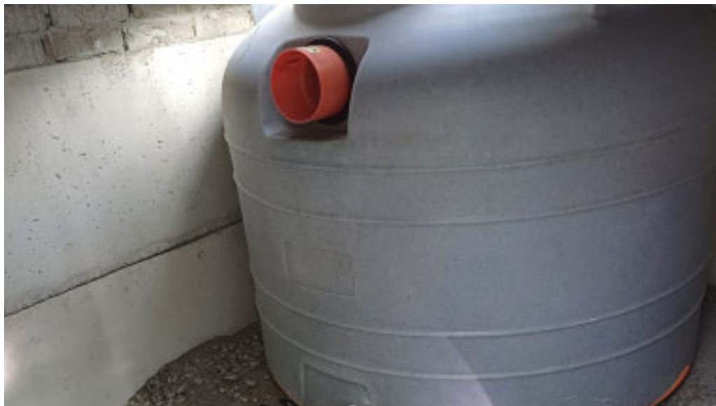
La cisterna interrata realizzata sotto il Toret
