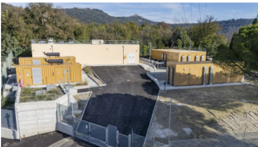
GRANAROLO ecco come si presenta l'esterno dell'Edge Data Center di Rai Way
