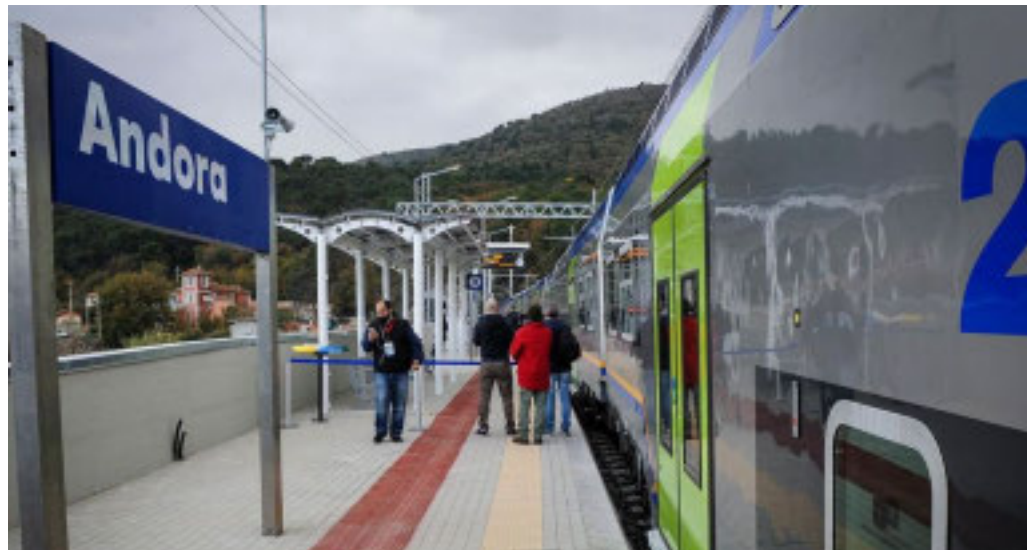
La stazione di Andora da dove dovrebbe partire il raddoppio dei binari verso Finale Ligure
