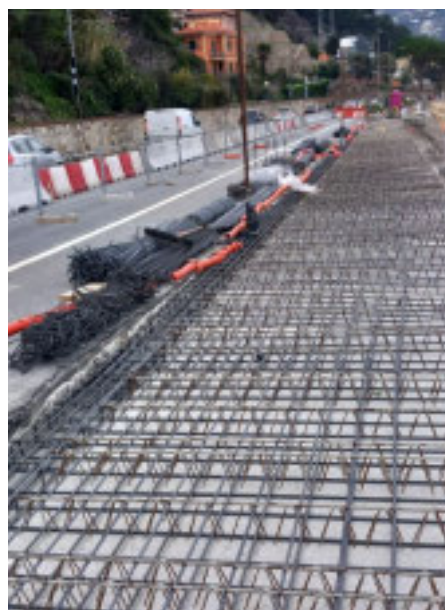
I lavori alla passeggiata Ciccione
