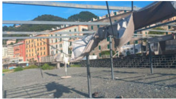
Ecco come sono state trovate le strutture delle tende
