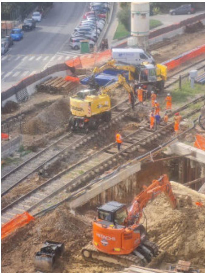
Gli scavi per l'eliminazione del passaggio a livello
