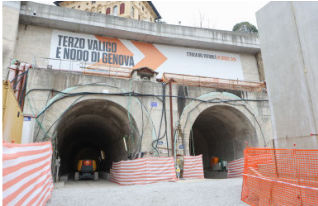
Siamo verso la conclusione dei lavori per il quadruplicamento tra Voltri e Sampierdarena
