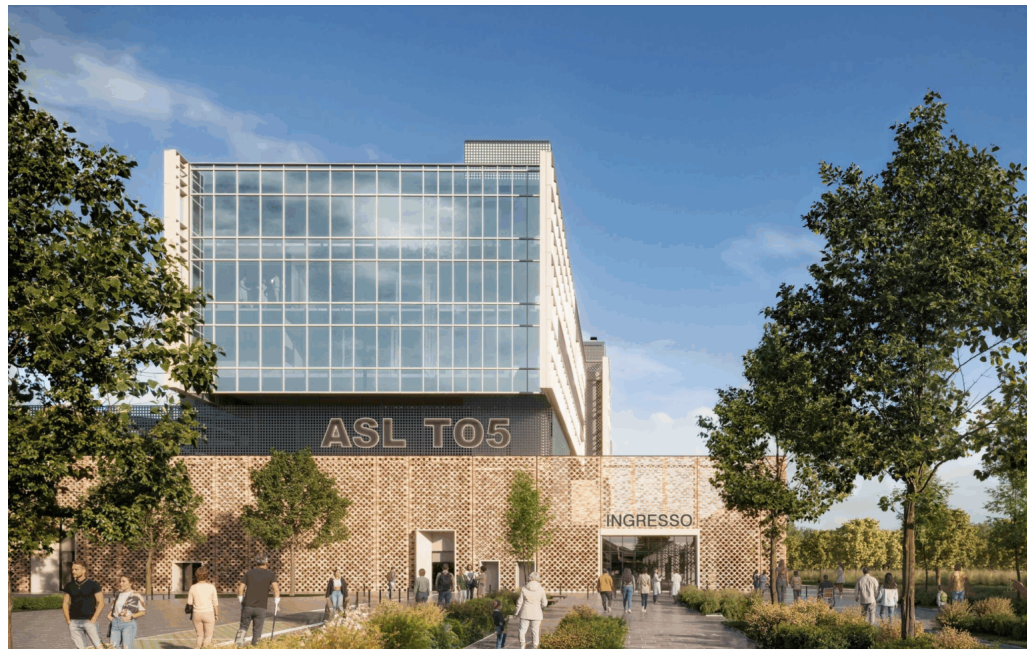
L'ospedale è tra i primi progettato completamente con il supporto dell'intelligenza artificiale
