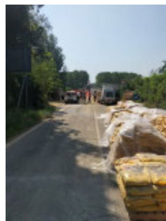
I lavori sul ponte di Bassignana
