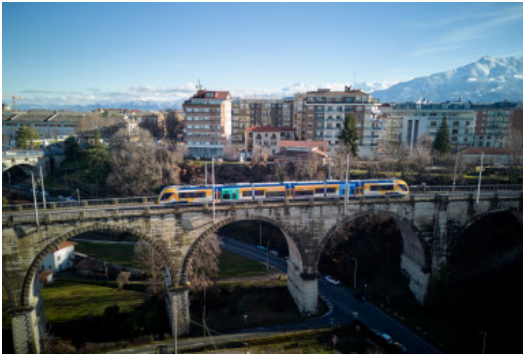
Un tratto cuneese della Ferrovia Cuneo-Breil-Ventimiglia
