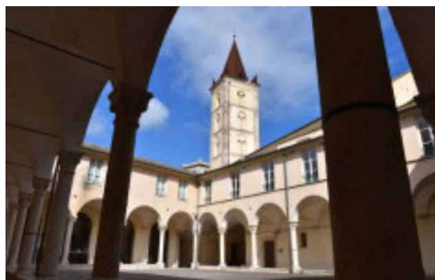
Il complesso monumentale di Santa Caterina di Finalborgo
