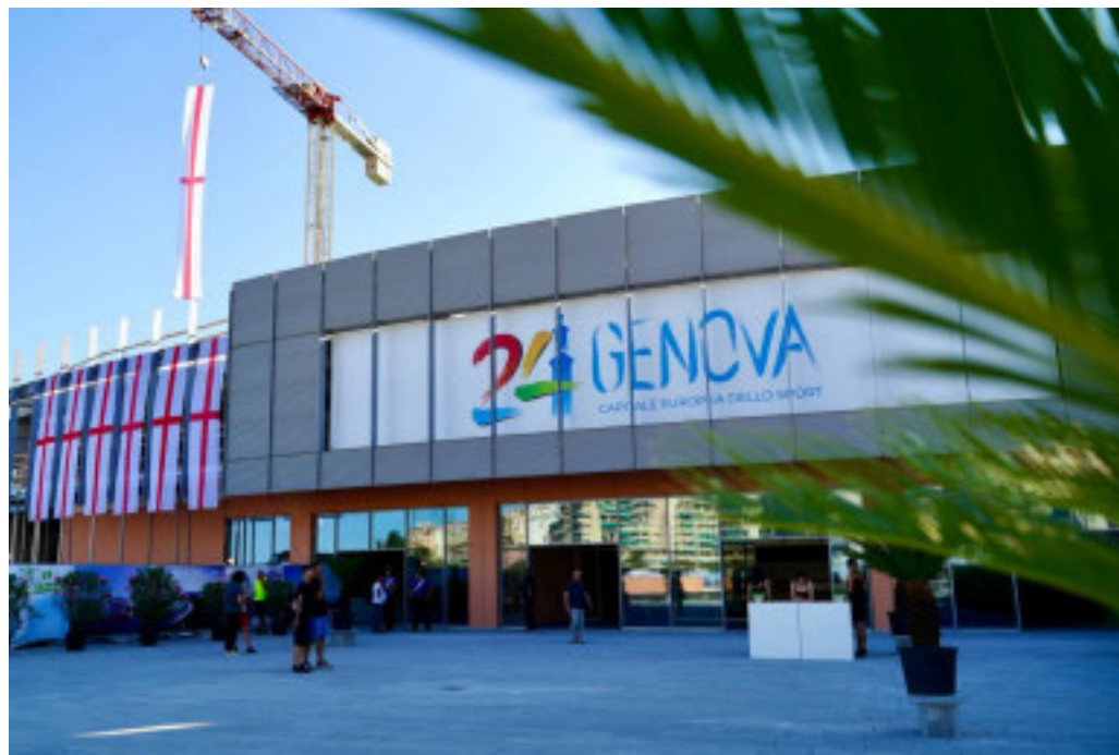
Il nuovo Palasport di Genova è tra gli elementi che riqualificano l'area del Waterfront
