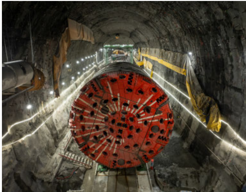
Sono stati aggiudicati tutti gli appalti civili e l'opera è tutta quanta in corso di realizzazione
