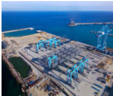
Il terminal portuale di Vado Ligure
