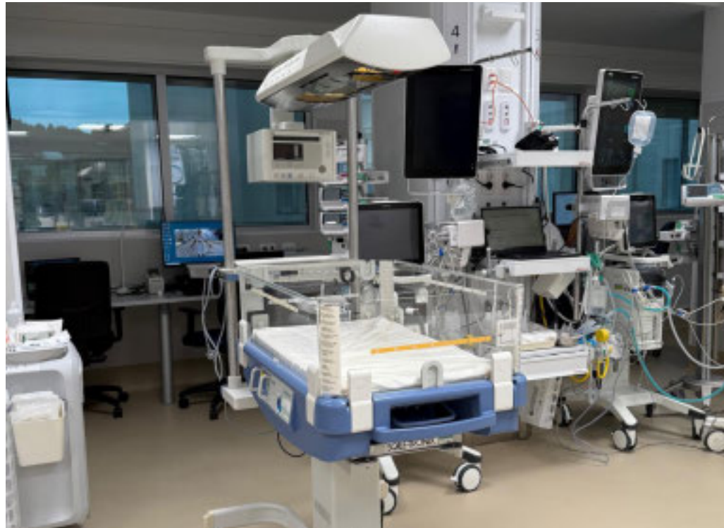
La ristrutturazione ha richiesto un investimento di 2,5 milioni di euro
