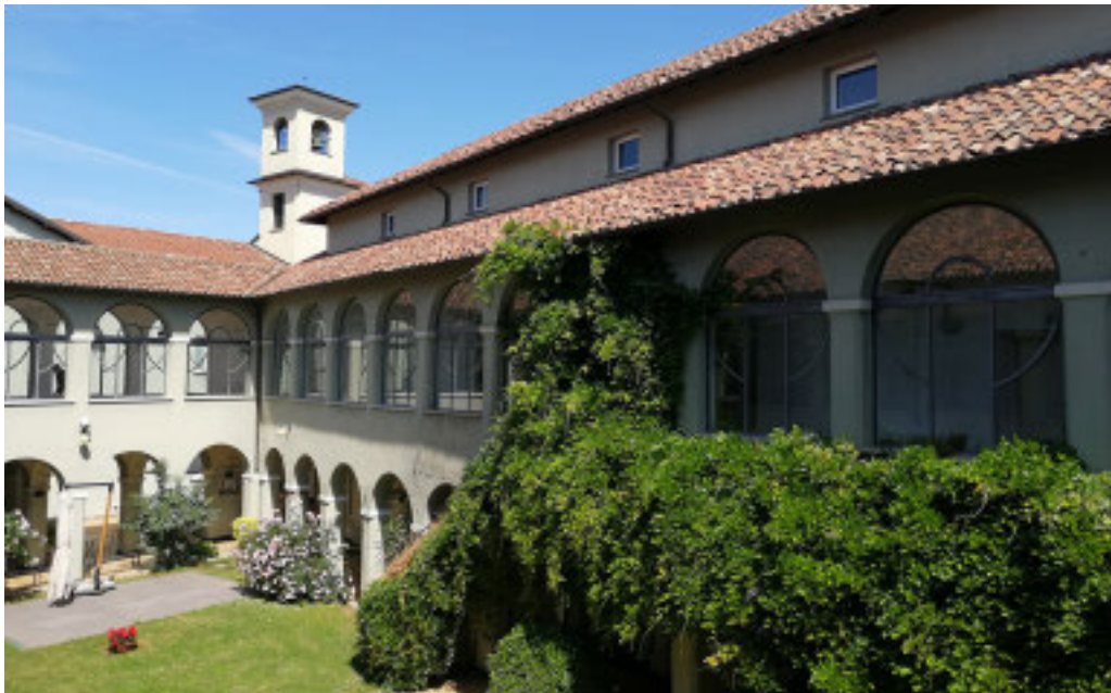
La Biblioteca di Novi Ligure
