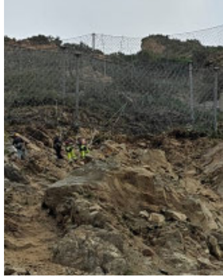
CONTRO LA FRANA Il primo intervento dopo il maltempo, il contenimento dei massi e la riparazione della volta
